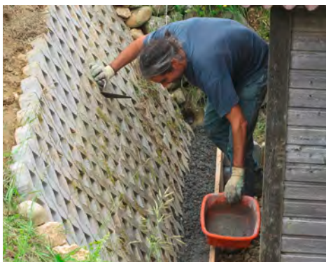
Petite semelle de béton pour sceller la base des grilles qui soutiennent le talus. Juste la place pour les pieds.
