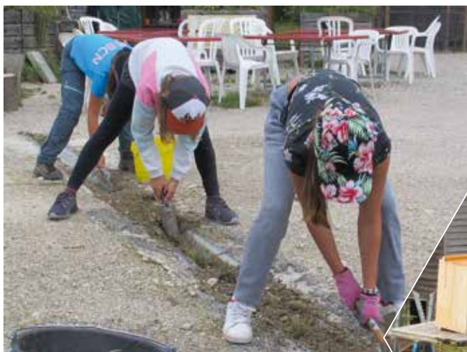
Curage de la rigole d'évacuation d'eau de surface...
