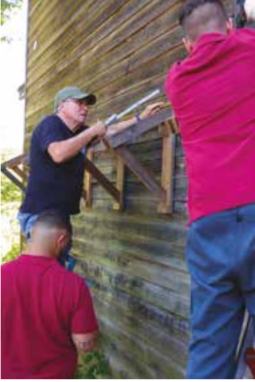
Daniel et des aides lors de la construction d'un avant-toit pour abriter les outils de jardin
